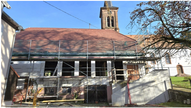
La rénovation du foyer paroissial bat son plein
