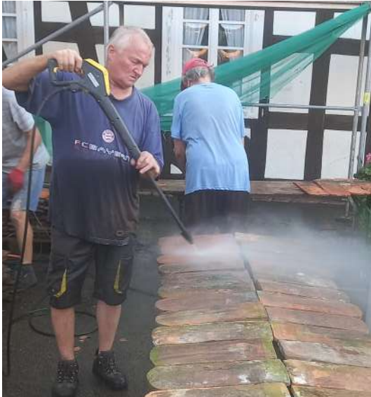
Merci aux bénévoles qui ont participé aux travaux de rénovation de la mairie
